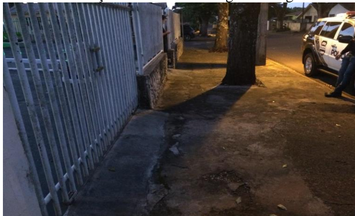
Foto 129 – Calçada defronte à Delegacia de Iguatemi
