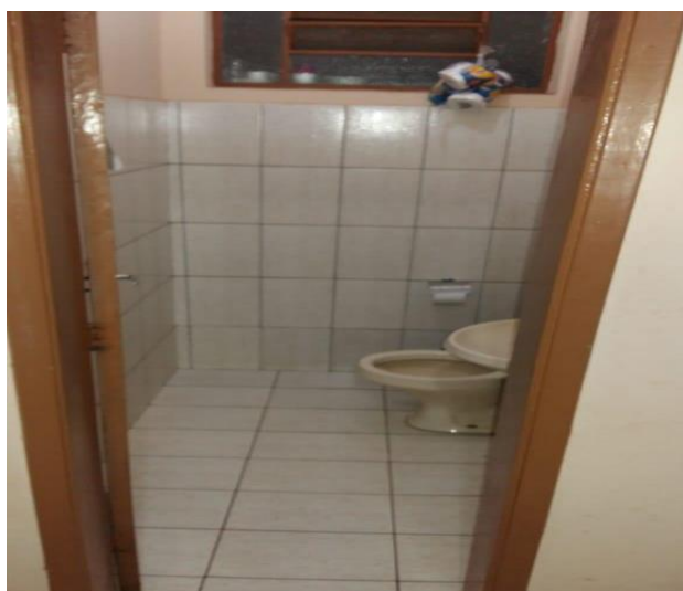
Foto 157 – Porta do banheiro
