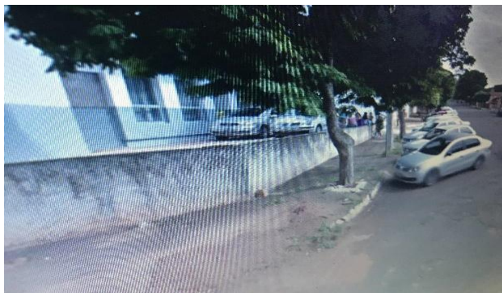
Foto 99 – Calçada defronte à Delegacia de Colorado
