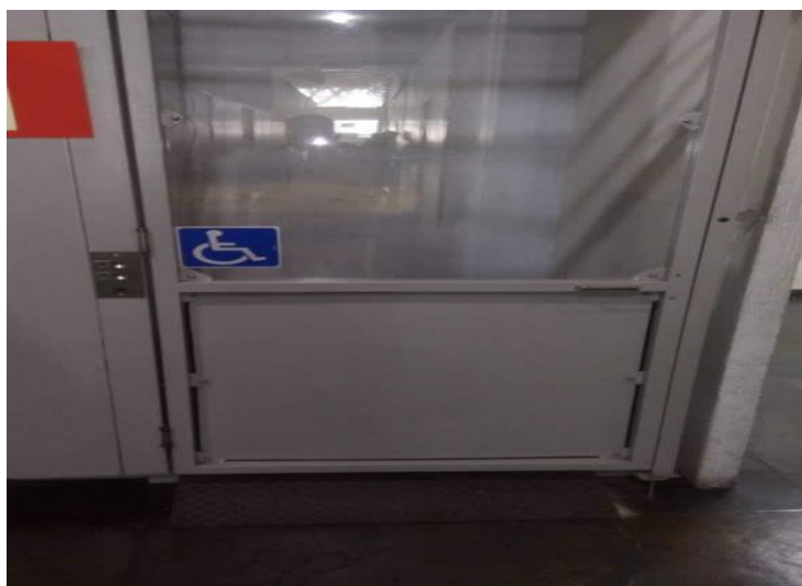
Foto 15 – Porta de acesso a sala de atendimento
