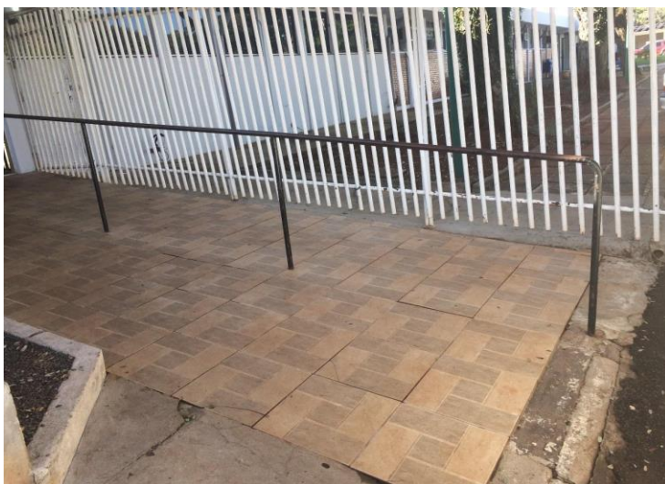
Foto 32 – Rampa de acesso ao setor de Plantão
