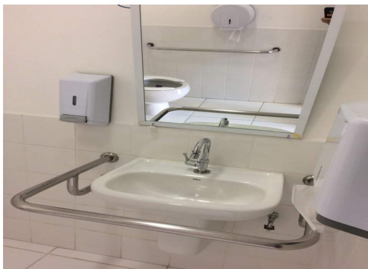
Foto 7 – Lavatório e torneira do banheiro
