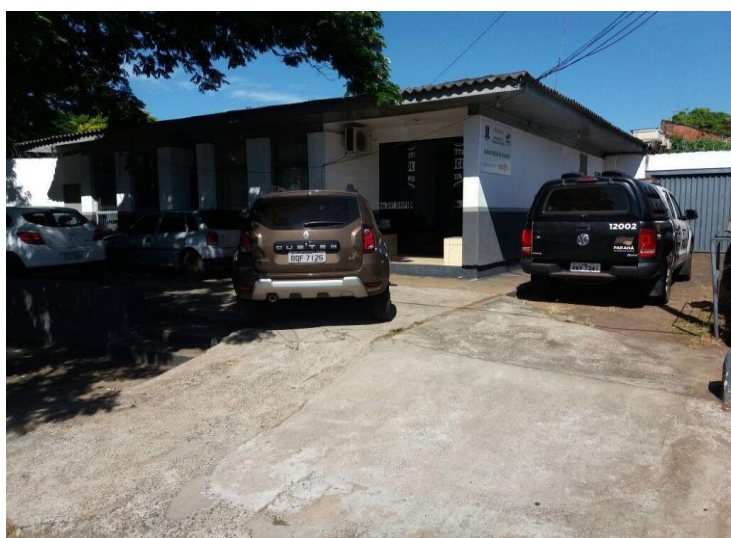
Foto 102 – Rampa de acesso a Delegacia
