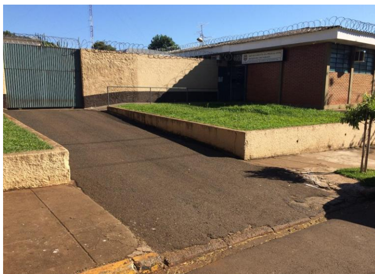
Foto 80 – Rampa de acesso a Delegacia
