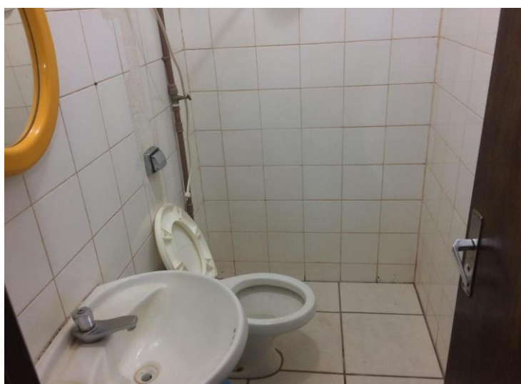
Foto 138 – Banheiro – vista interna
