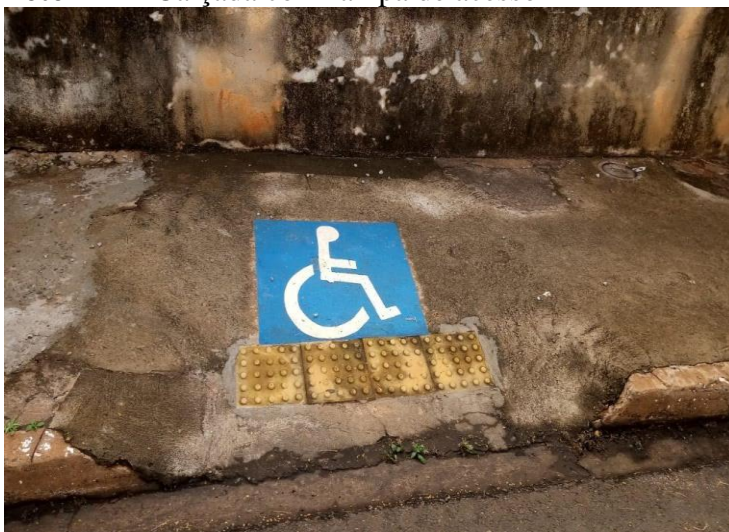
Foto 122 – Calçada com rampa de acesso
