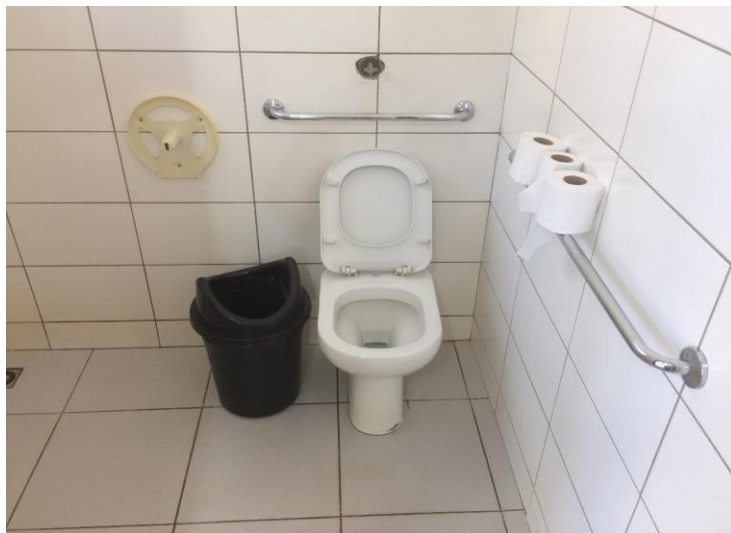
Foto 37 – Parte interna do banheiro do setor de plantão
