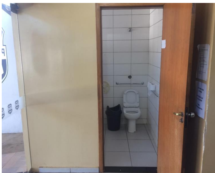
Foto 36 – Entrada do banheiro do setor do plantão
