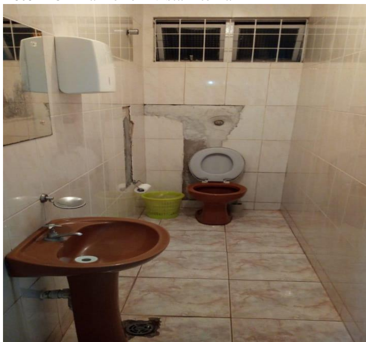
Foto 128 – Banheiro – vista interna
