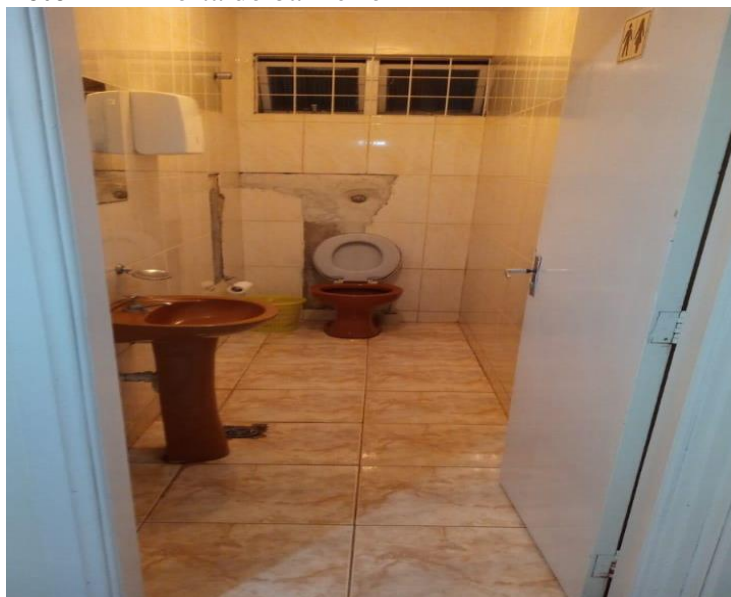
Foto 127 – Porta do banheiro
