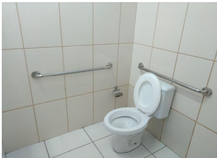
Foto 97 – Banheiro – área interna
