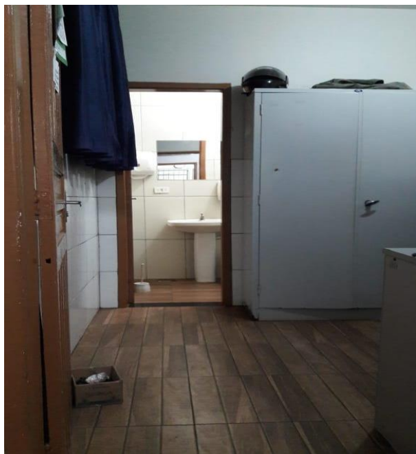
Foto 87 – Acesso ao banheiro
