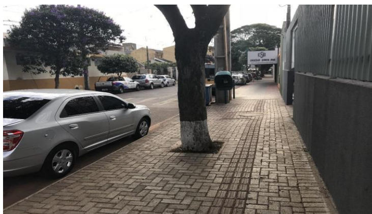
Foto 60 – Calçada defronte à Delegacia de Sarandi
