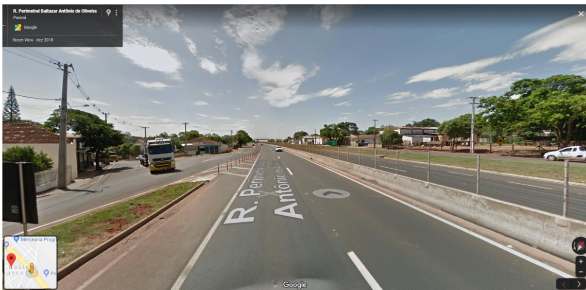
Figura 27 – Entrada da cidade após a obra
