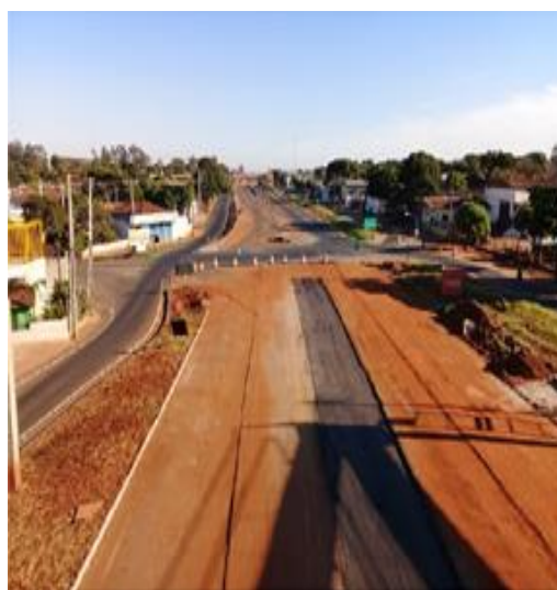
Figura 26 - Entrada da cidade durante a obra
