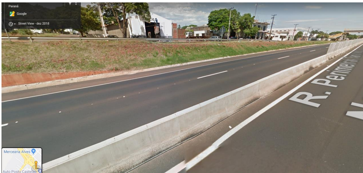
Figura 33 – Rodovia duplicada e sem acesso ao comércio lindeiro à pista
