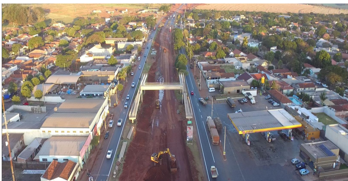
Figura 23 - BR-376 em obras para duplicação
