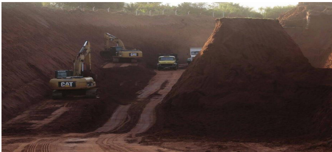
Figura 22 - Máquinas trabalhando no rebaixamento da pista
