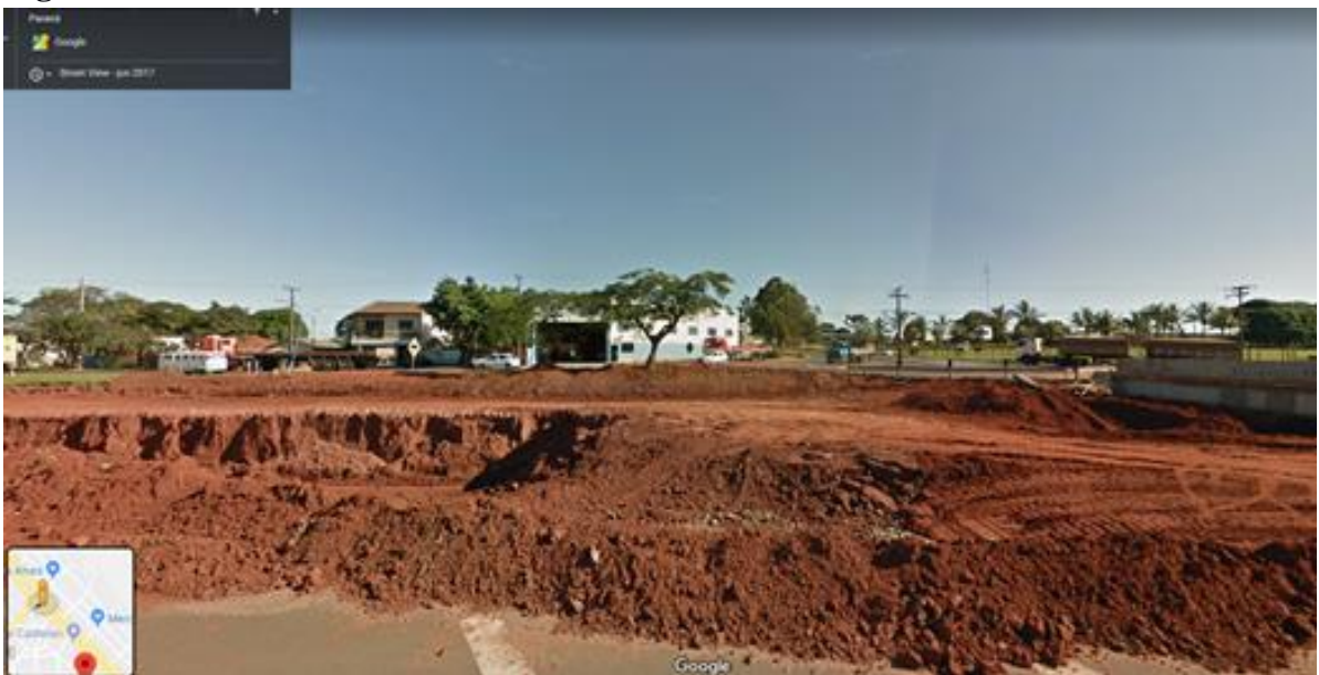
Figura 21 Amontoado de terra sobre a rodovia
