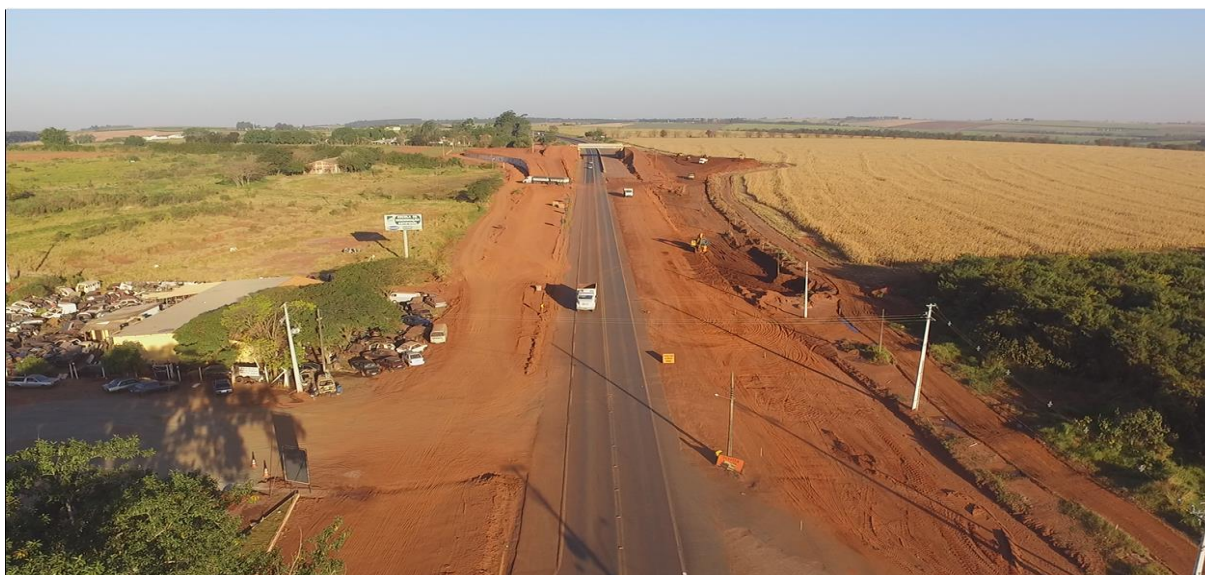
Figura 31 - Vista aérea da construção do trevo na saída para Maringá
