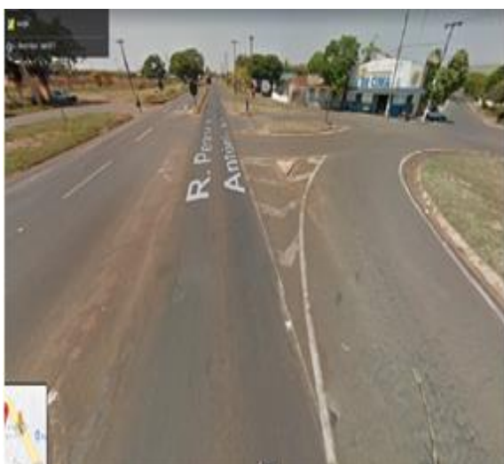
Figura 25 - Entrada da cidade antes da obra
