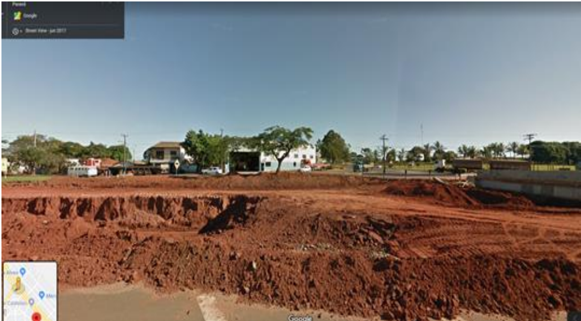
Figura 17 – Obras na BR-376 em Presidente Castelo Branco
