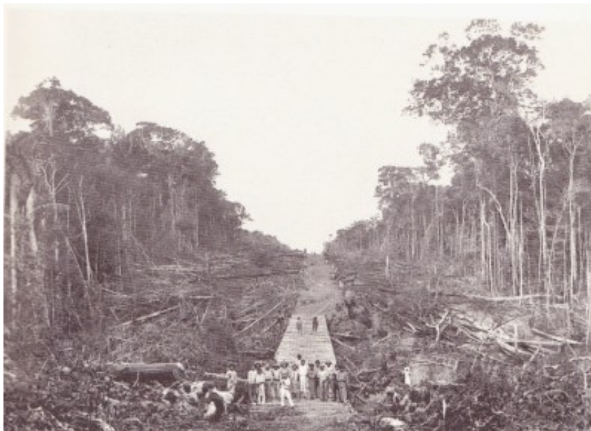
Figura 3. Derrubada de árvores para abrir caminho às linhas telegráficas em 1913.
