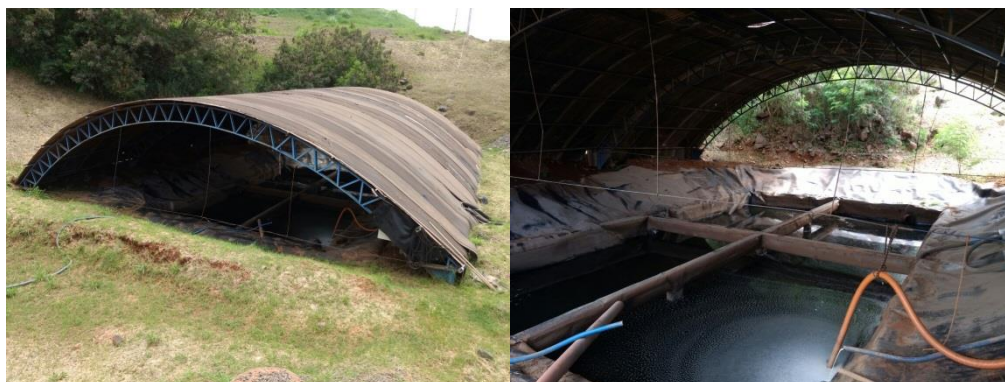
Figura 11 – Tanque de coleta do lixiviado
