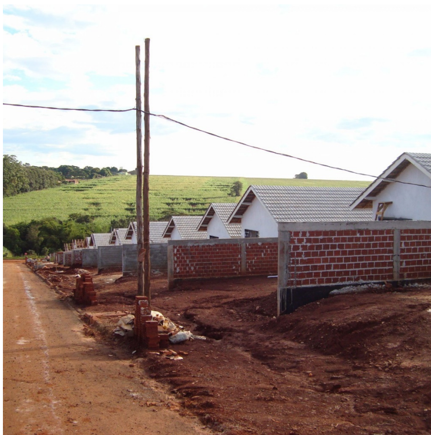
Imagem 1– Jardim Oriental em construção.
