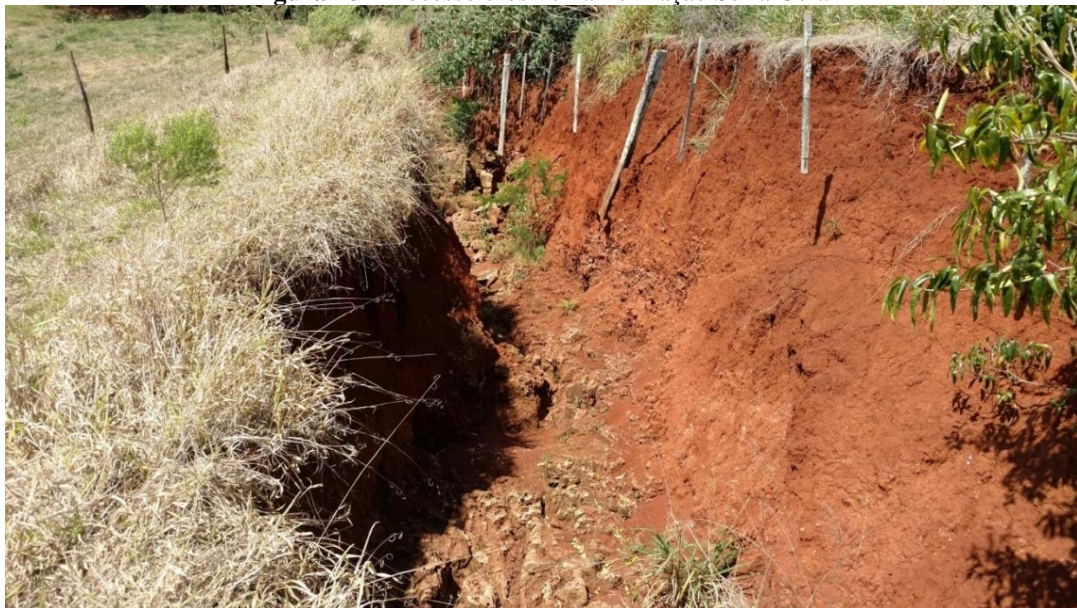
Figura 18 - Processo erosivo na Formação Serra Geral
