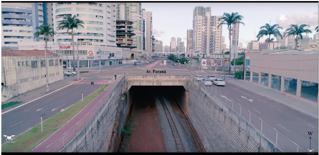
Figura 5.19 – Início do túnel da linha férrea
