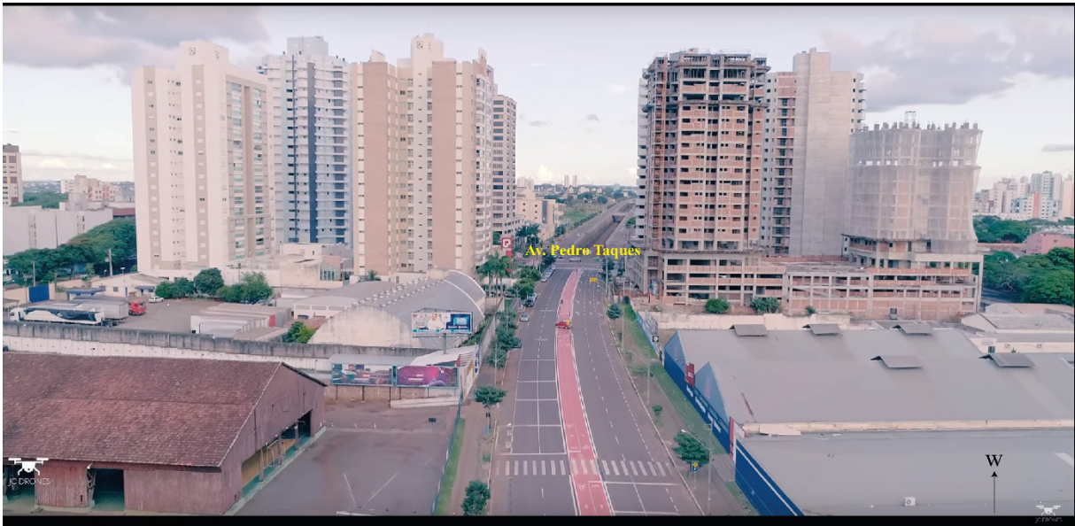
Figura 5.23 – Antigo setor de armazéns e final do túnel do Novo Centro, Maringá, PR
