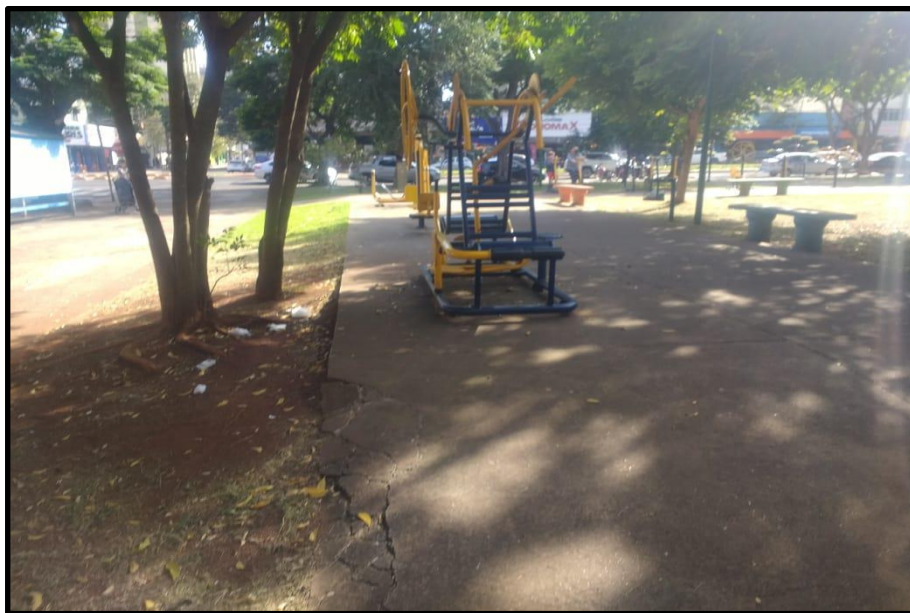
Figura 10: Piso com manutenção deficiente da Praça Napoleão Moreira da Silva
