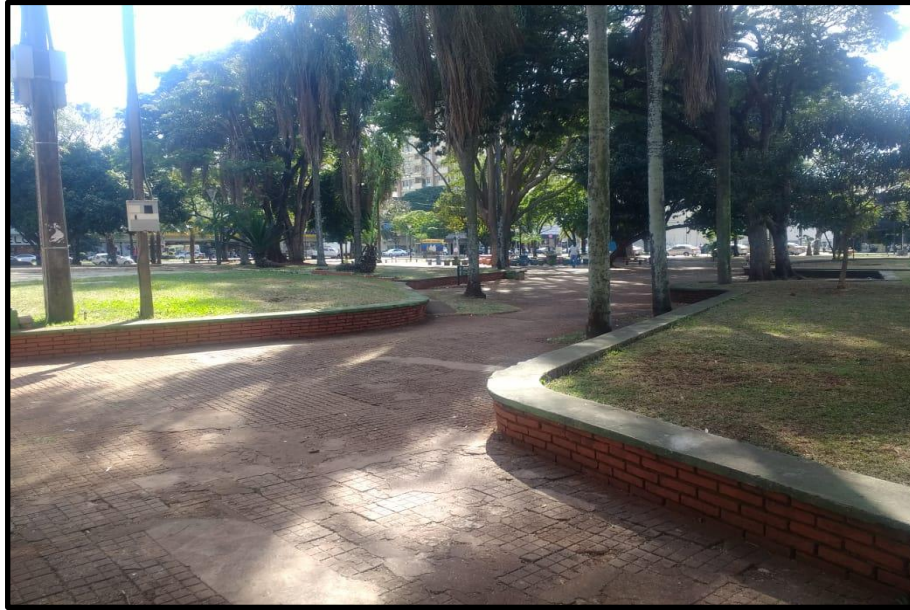
Figura 6: Banco adaptado sobre mureta de contenção da Praça Napoleão Moreira da Silva
