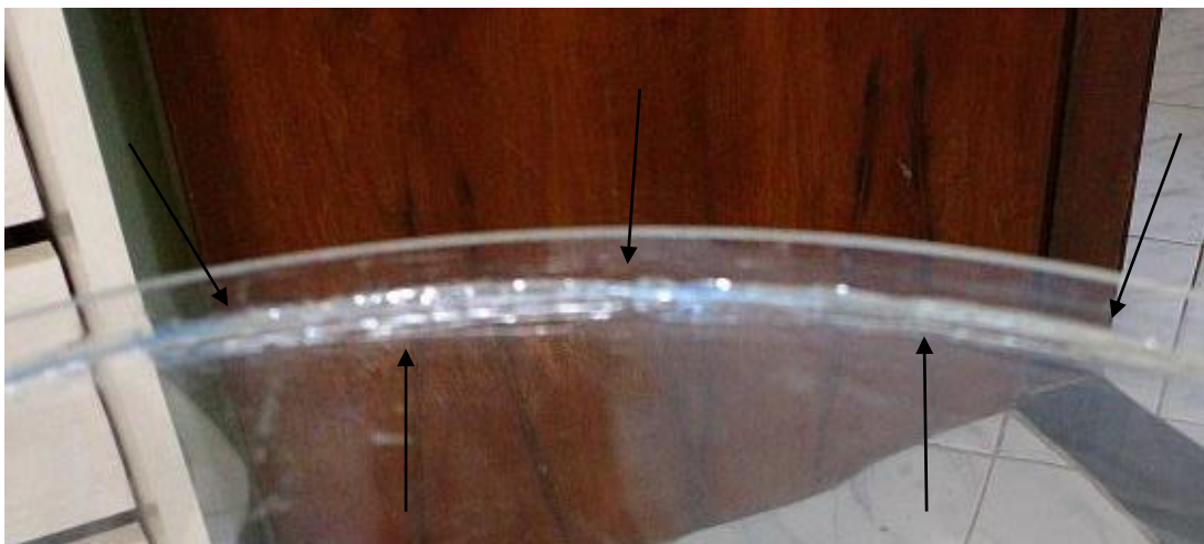
Figura 8. Emenda da base do tanque de acrílico.
