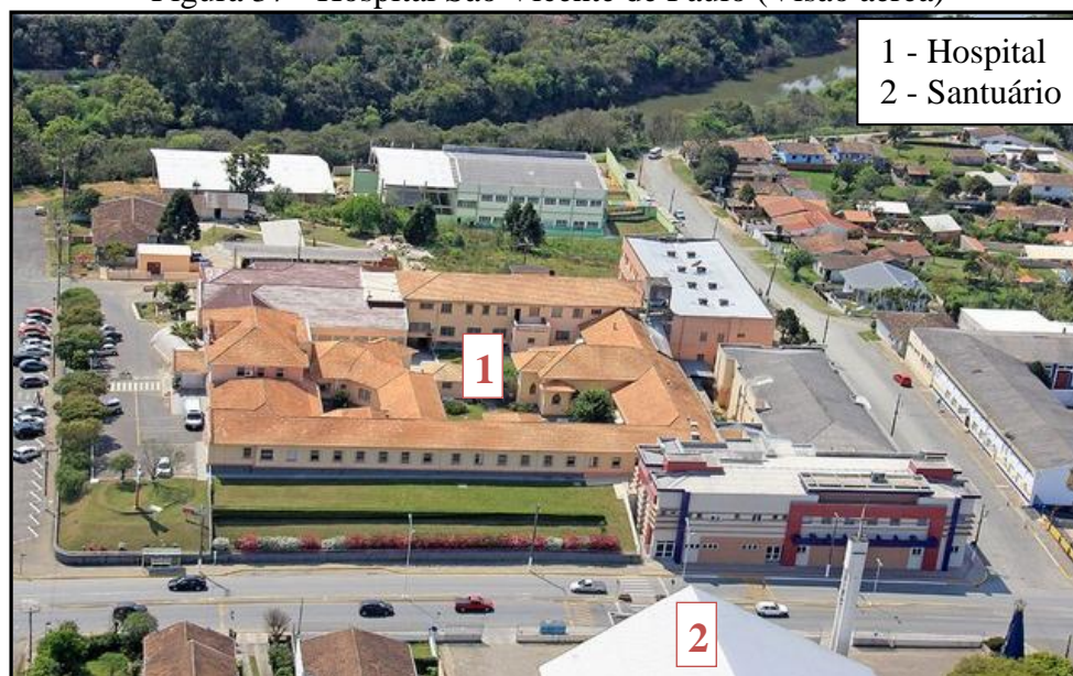
Figura 37 - Hospital São Vicente de Paulo (Visão aérea)
