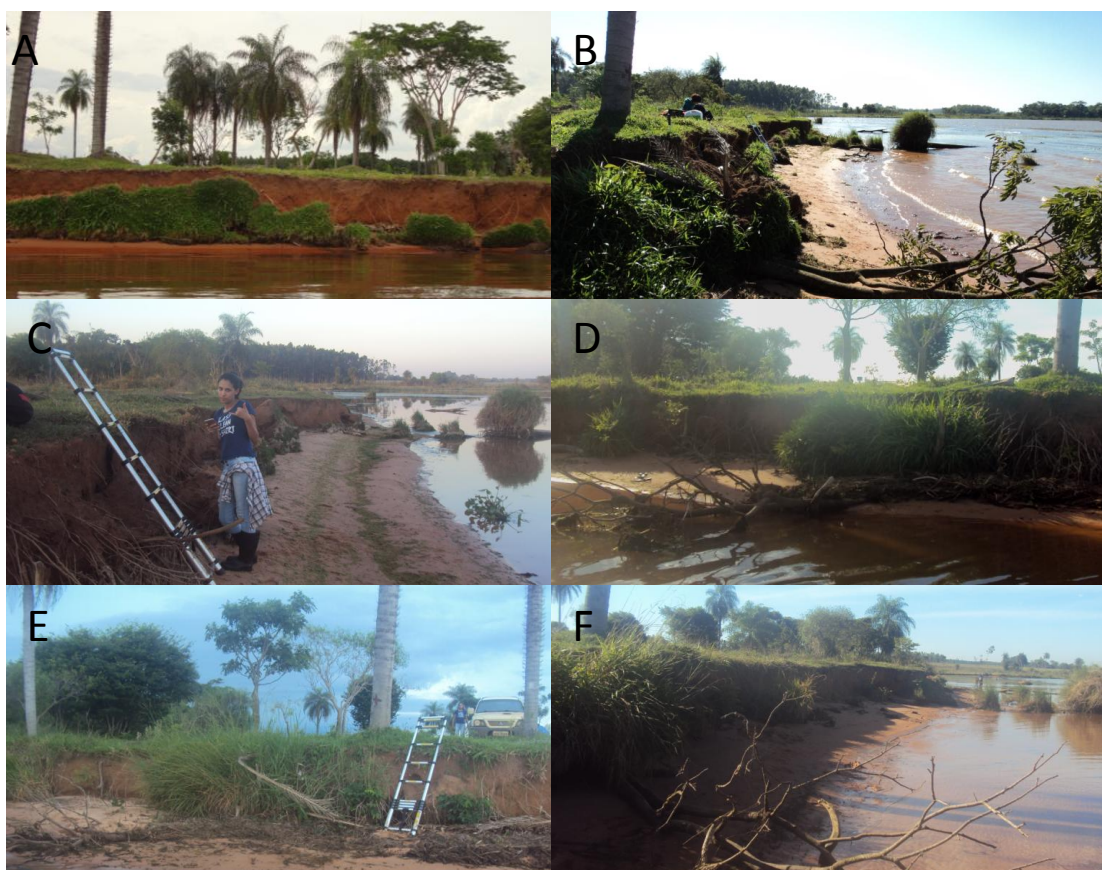
Figura 38 - Feições erosivas no ponto de monitoramento 5, abrangendo o primeiro levantamento de campo em 25/11/2016 (A) e os monitoramentos 1 (B), 2 (C), 3 (D), 4 (E) e 5 (F)
