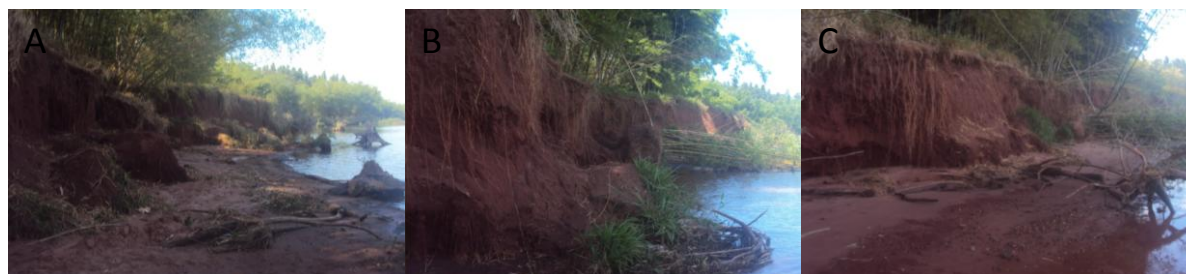
Figura 34- Variação temporal das feições erosivas adjacente ao ponto de controle 3 em junho de 2017 (A), em dezembro de 2017 (B) e em junho de 2018 (C)
