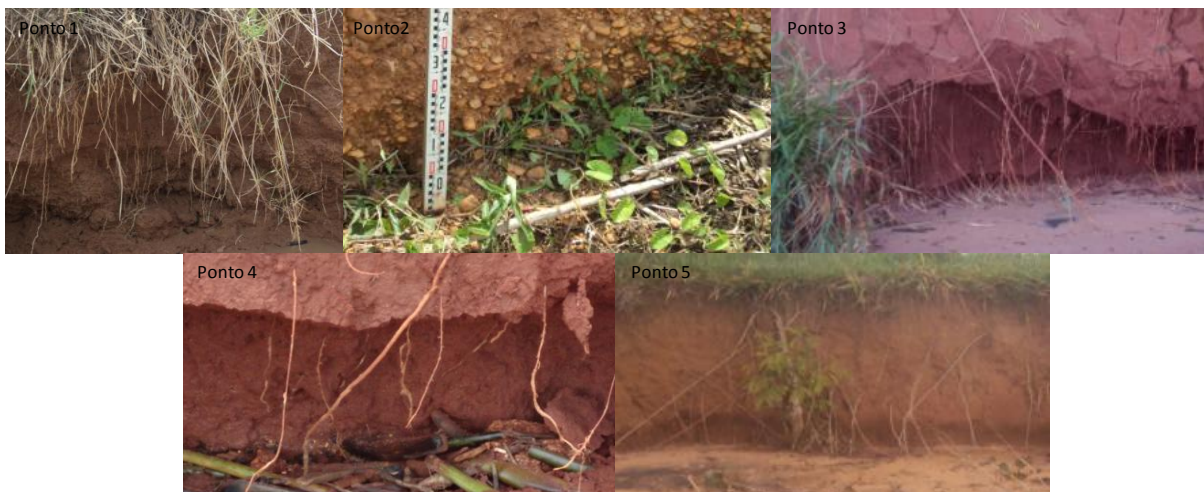
Figura 28 - Solapamento da base dos talude nos pontos de controle, no reservatório da UHE Rosana (SP/PR)
