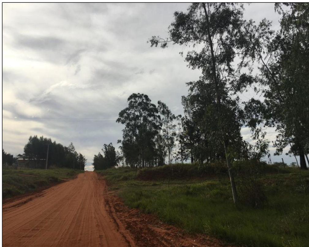
Figura 55 – Estrada de acesso ao porto Novo em Icaraíma
