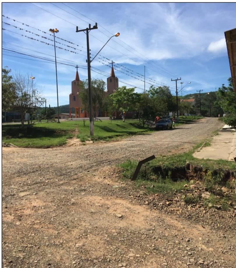
Figura 52– Avenida e Praça Central de Tereza Cristina
