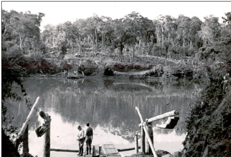
Figura 34 – Balsa do porto Metrópole em 1948
