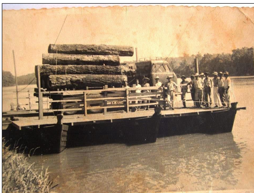
Figura 58 - Balsa do Porto Figueira localizada em Itambé
