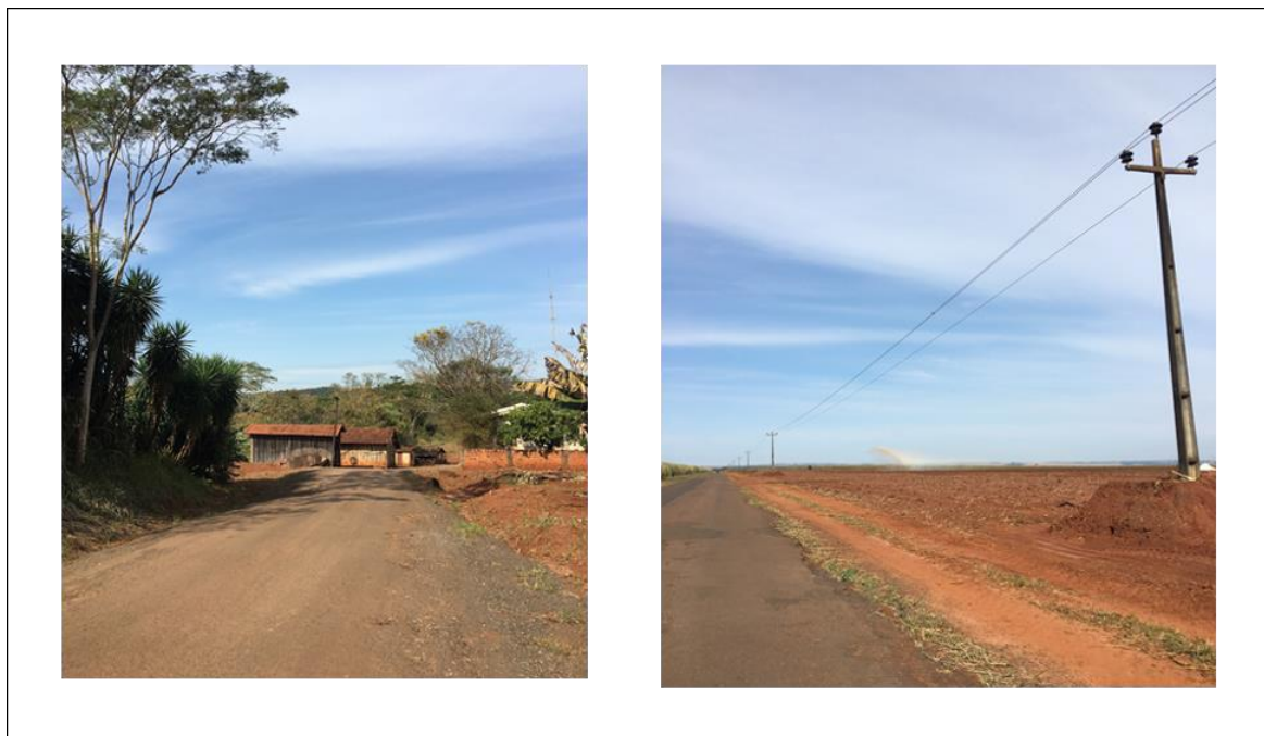
Figura 56 – Mosaico da Rodovia PR 082: acesso a balsa Santo Antônio
