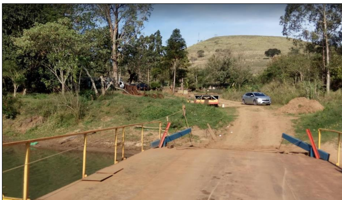
Figura 53 - Ancoradouro e via de acesso para balsa do Marollo
