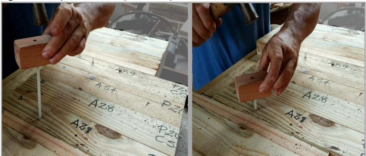
Figura 54: Inserção da cavilha no pré-furo dos painéis.
