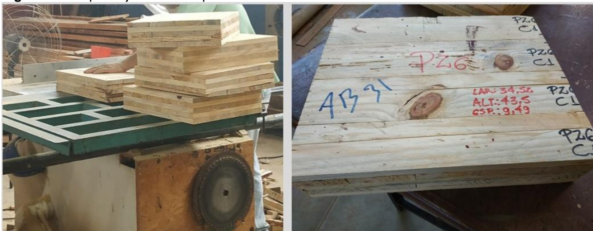
Figura 76: Esquadreamento dos painéis.
