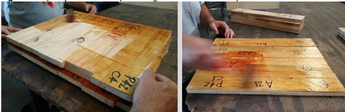
Figura 74: Aplicação de adesivo para colagem das camadas dos painéis CLT.
