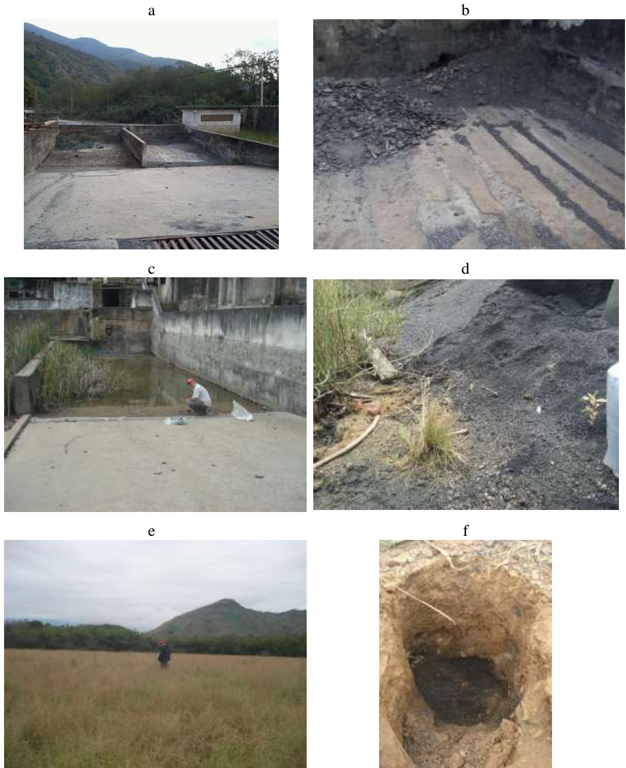
Figura 03: Baias onde era depositado o resíduo após processo de extração (a), resíduo a ser encaminhado para o aterro (b), baia onde era depositado o resíduo com acúmulo de água (c), pilha de resíduo no pátio da mineradora (d), aterro sanitário para deposição do resíduo (e) e resíduo recoberto com uma camada de aproximadamente 40 cm de solo na área do aterro (f).
