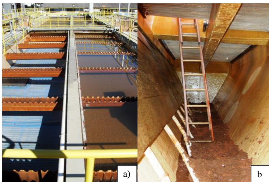
Figura 6 – a) Vista superior do decantador. b) Vista interior do decantador.
