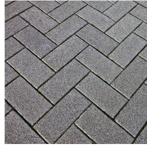
(b) Pavimentação por Paralelepípedos.
