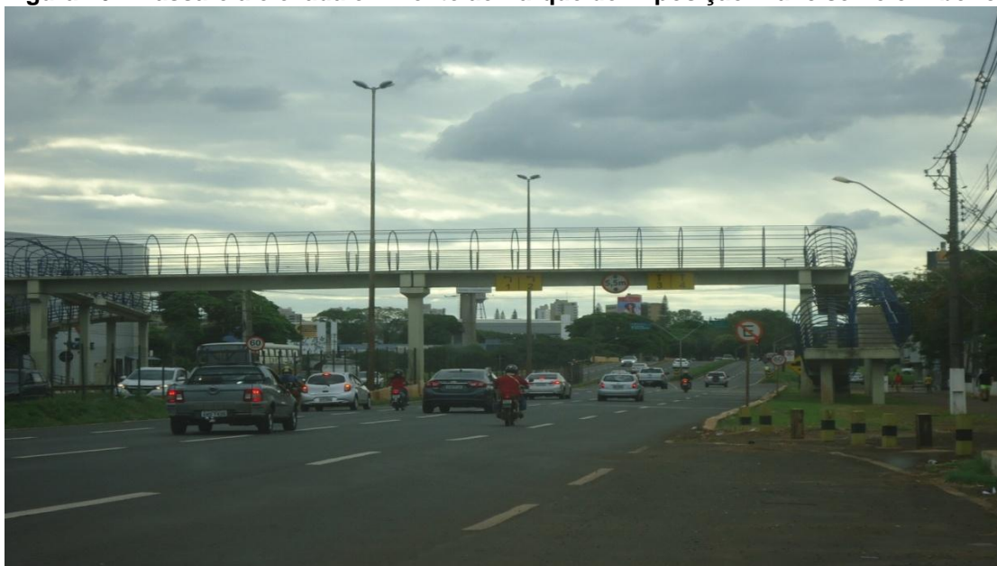
Figura 26 – Passarela elevada em frente ao Parque de Exposição Franciso Feio Ribeiro
