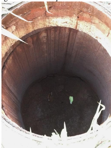
Figura 16 – Indicação do PV 16 seco
