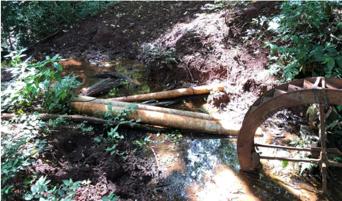
Figura 11 - Sinais de assoreamento na nascente do Ribeirão Ema (janeiro de 2021)
