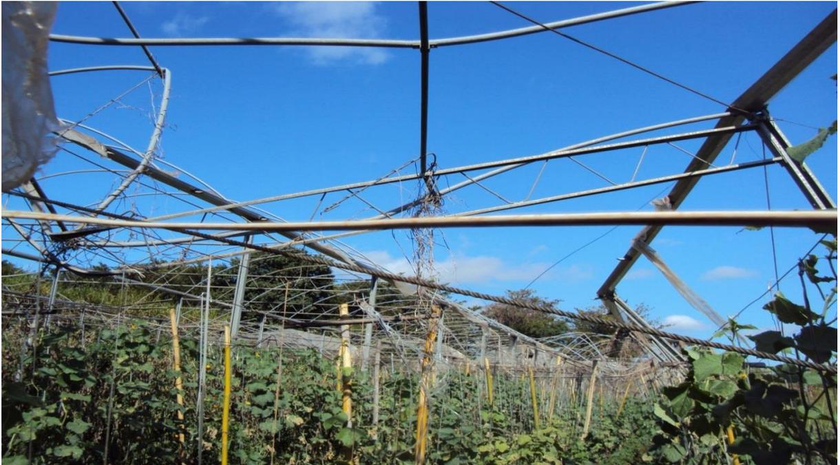
Figura 33. Estrutura metálica para cultivo protegido, destruição por vendaval.
