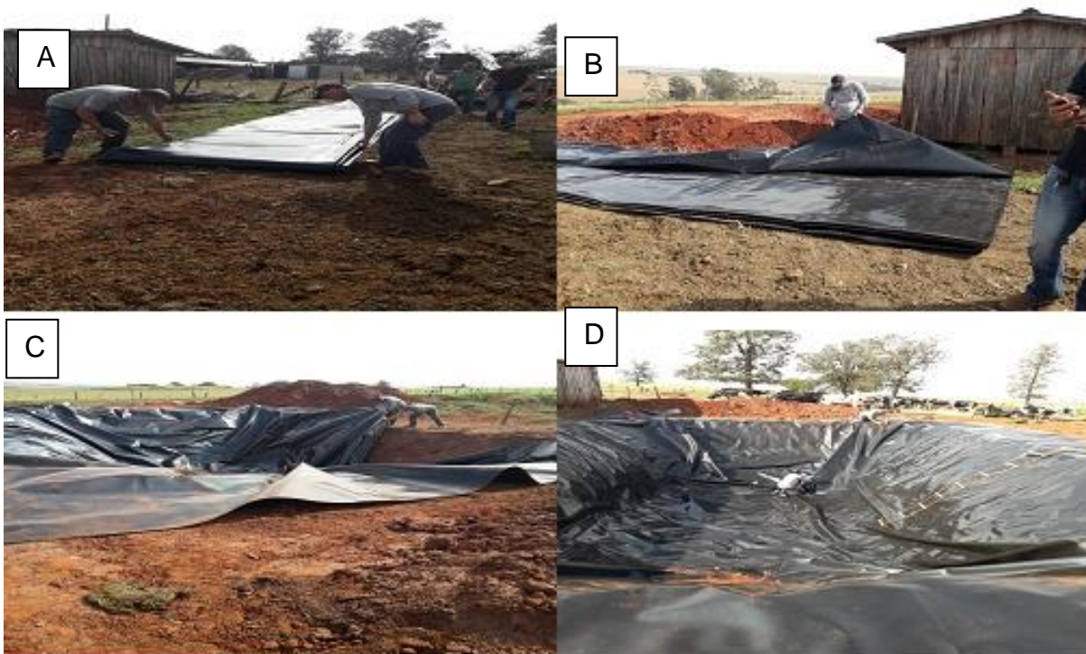
Figura 3 (A, B, C, D) abertura e colocação da manta plástica de PEAD sobre o local escavado.
