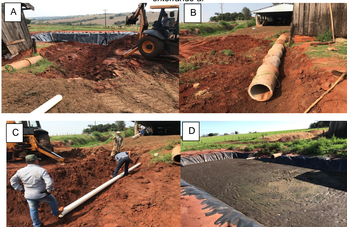
Figura 4 (A, B, C) disposição dos tubos para entrada dos dejetos e saída do biofertilizante. (D) esterqueira finalizada com demonstração da fixação do perímetro da manta plástica, enterrando-a.
