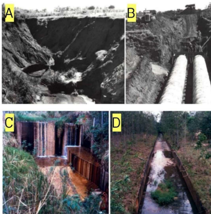
Figura 37 – Construção do Parque das Grevíleas
