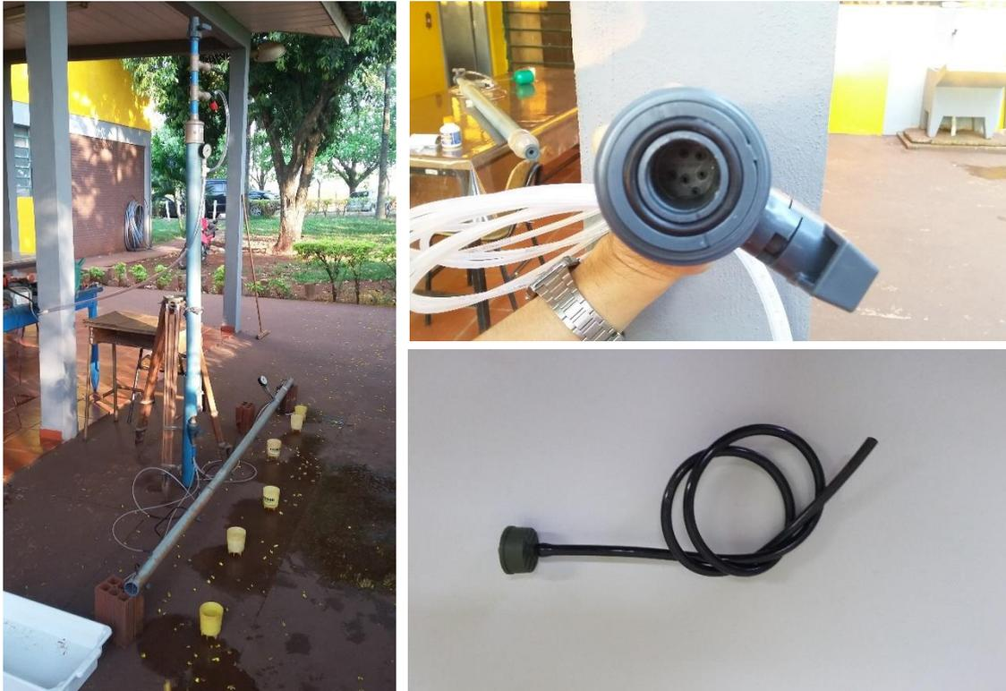
Figura 1. Vista parcial do sistema portátil de fertirrigação e detalhamento do conjunto microtubo-gotejador e do registro de esfera contendo as seis derivações.
