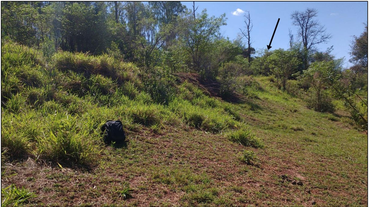
Figura 34 - Vista parcial do terraço a montante da voçoroca 21
