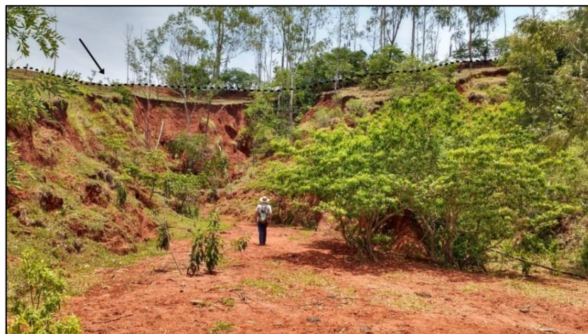
Figura 38 - Vista parcial da voçoroca 27
