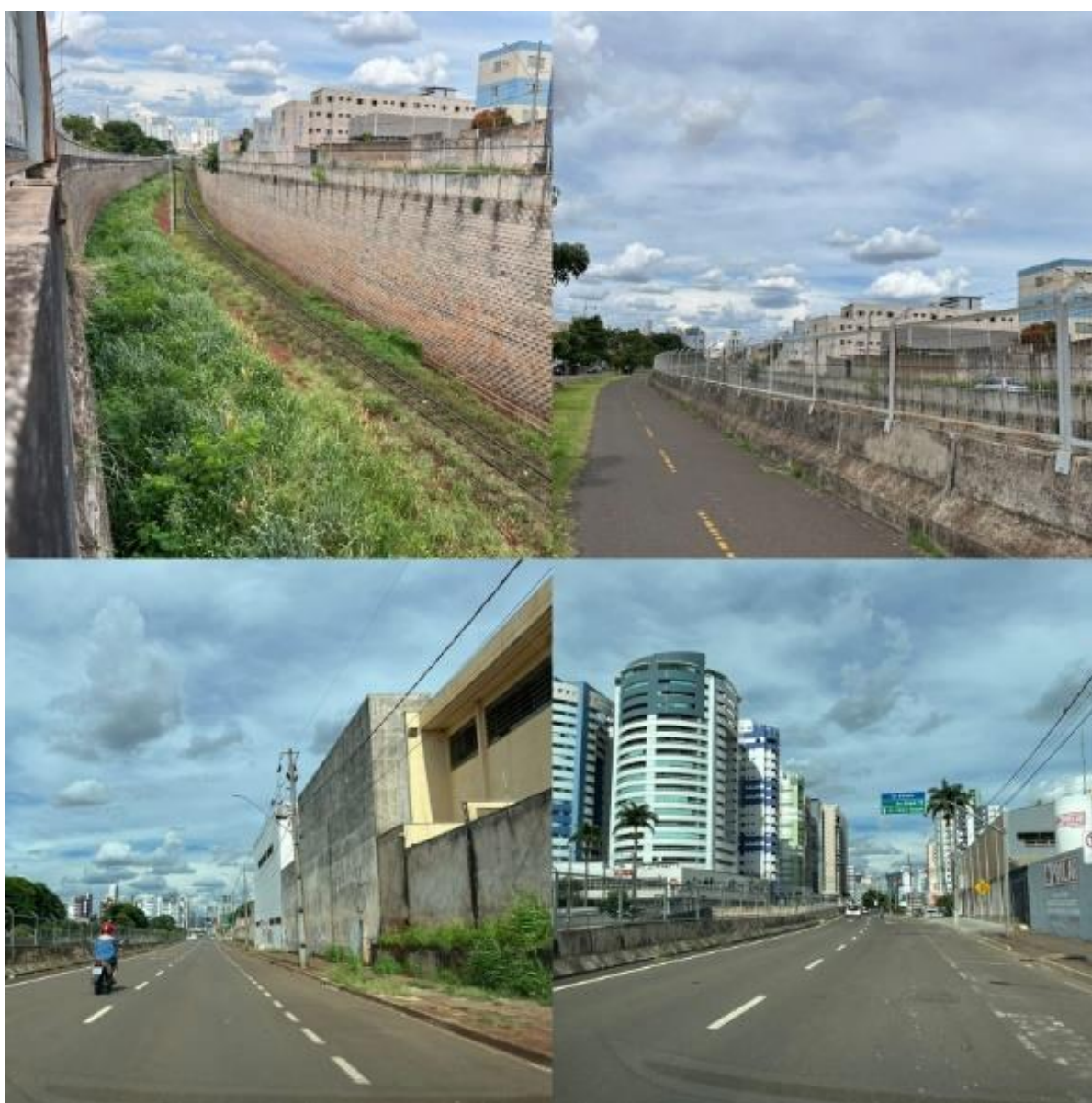
Figura 25: Rebaixamento da Linha Férrea
