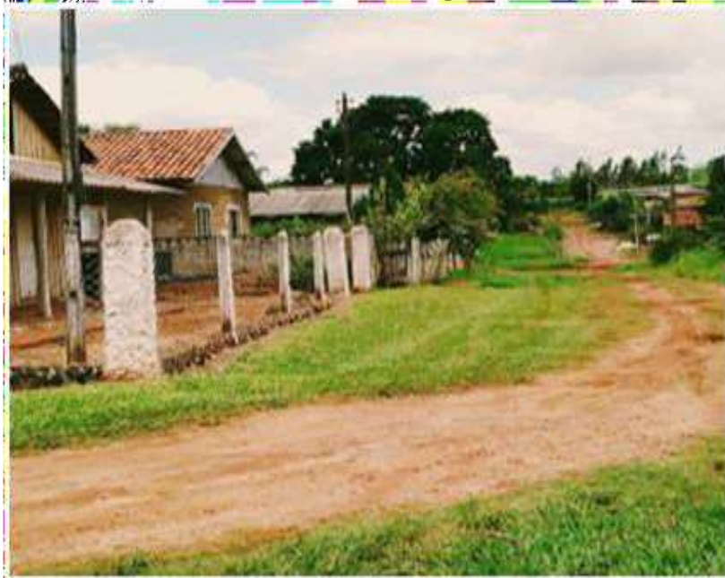
Figura 6 – Graciosa. Rua com falta de pavimentação asfáltica, 2023
