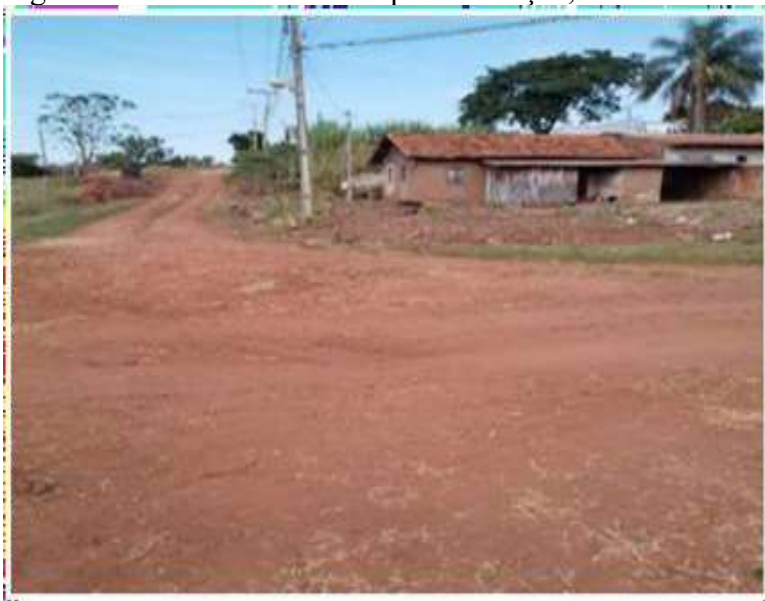
Figura 7 – Graciosa. Rua sem pavimentação, 2023
