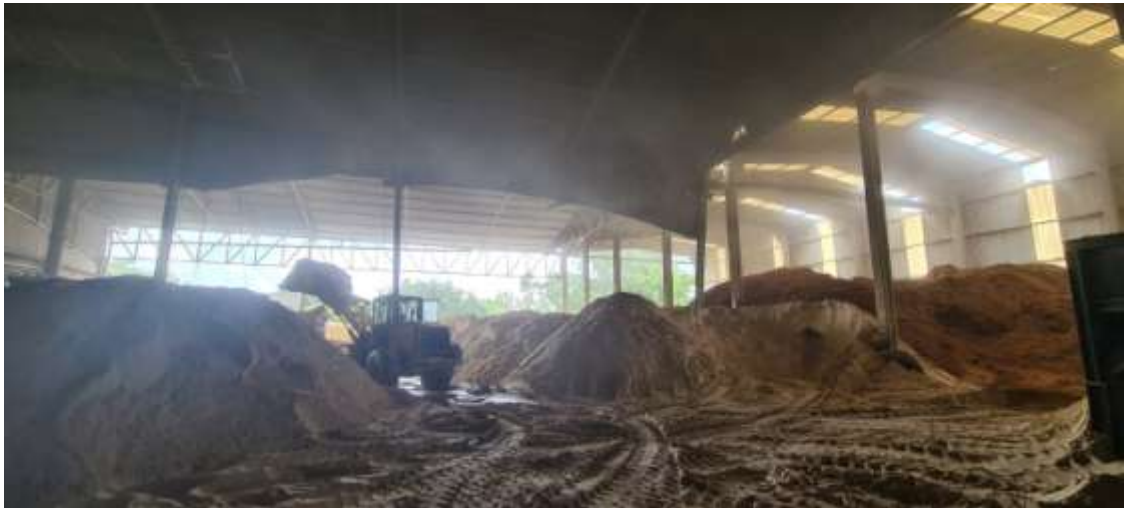
Figura 26 - Armazenagem de areia
