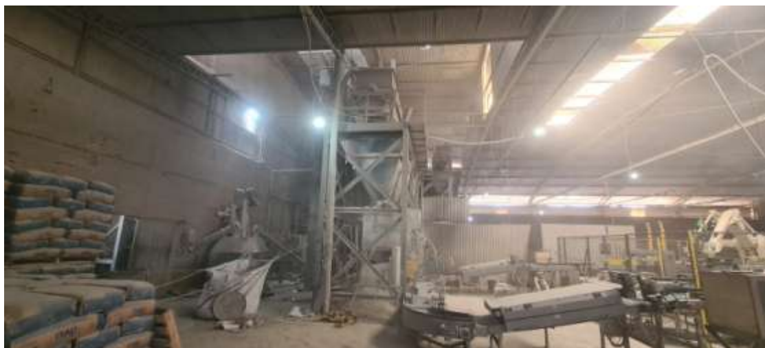
Figura 27 – Mistura da argamassa
