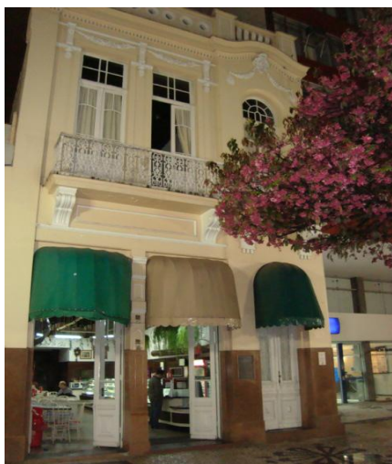
Figura 5 - Fotografia da fachada da confeitaria.
