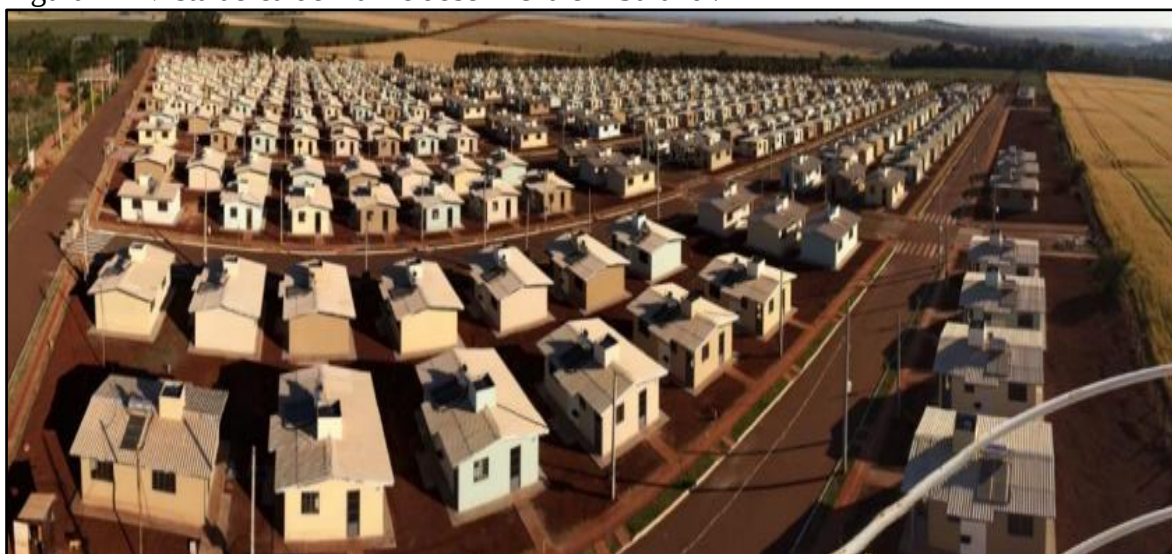
Figura 1 – Vista aérea do Bairro José Richa em Sarandi/PR
