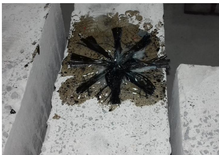
Figura 43 – Sistema de ancoragem aplicado
