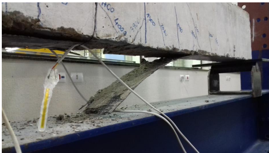
Figura 71 – Panorama de fissuração – Viga VF1
