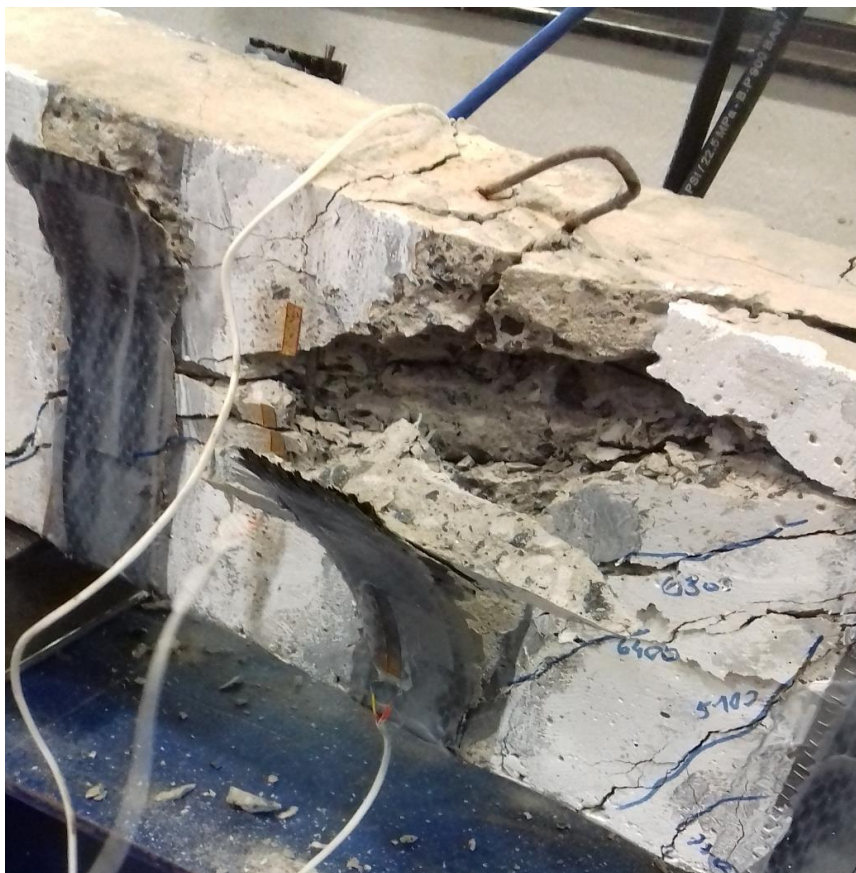
Figura 85 – Panorama de fissuração– Viga VC1
