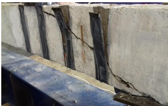
Figura 82 – Descolamento do reforço – Viga VC0-90
