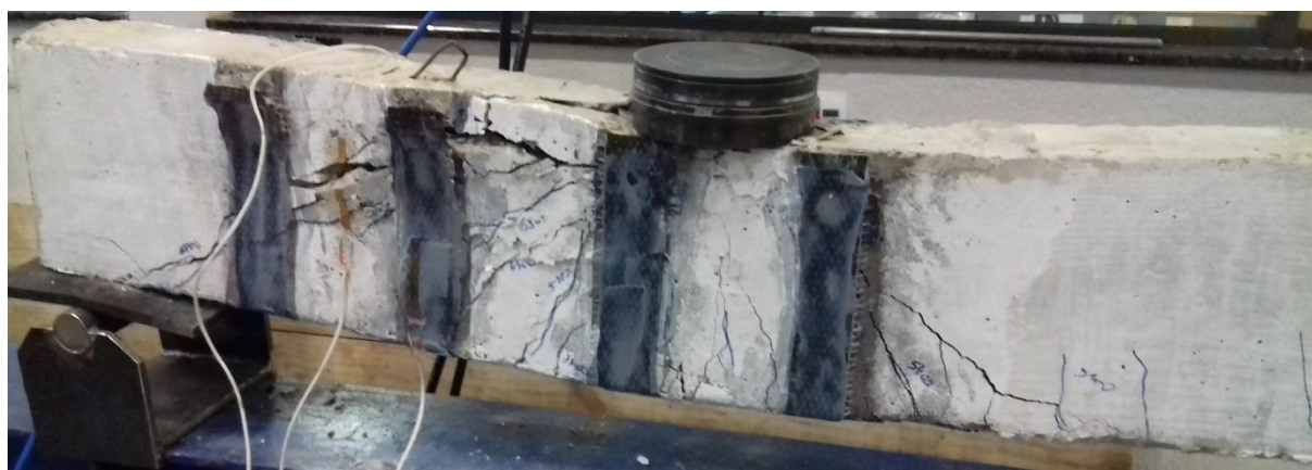
Figura 86 – Fissuras – Viga VC1
