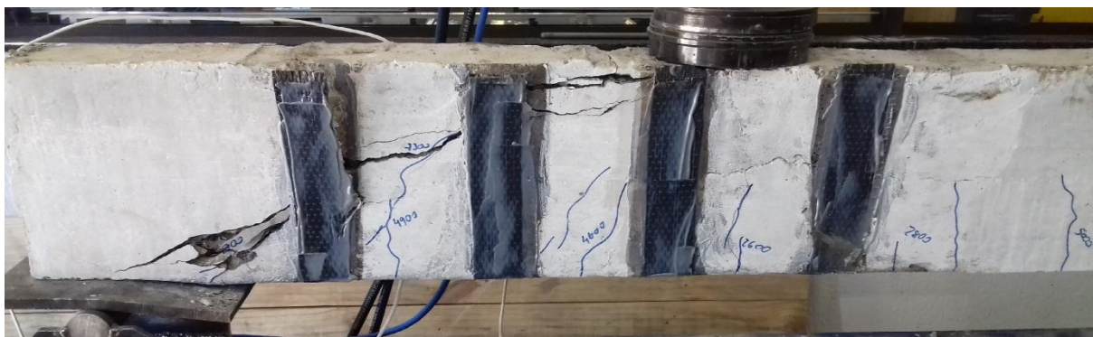
Figura 83 – Fissuras – Viga VC0-90
