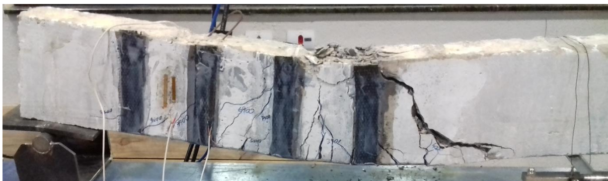
Figura 88 – Fissuras – Viga VC2
